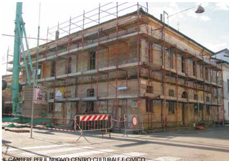
IL CANTIERE PER IL NUOVO CENTRO CULTURALE E CIVICO
